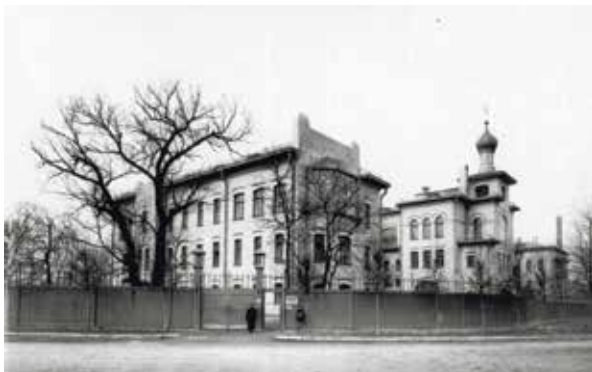
Здание Ортопедического института в Александровском парке, д.5
