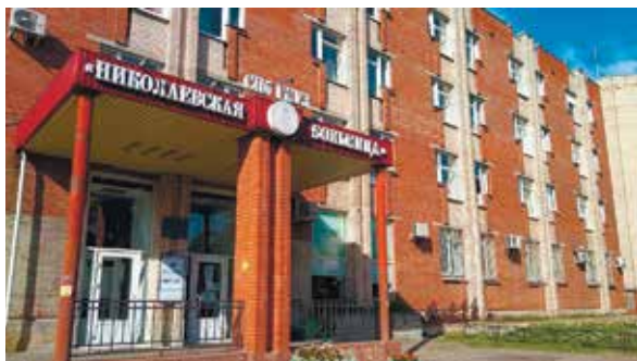
Здание Николаевской больницы (Петергоф, Константиновская ул., д.1)
